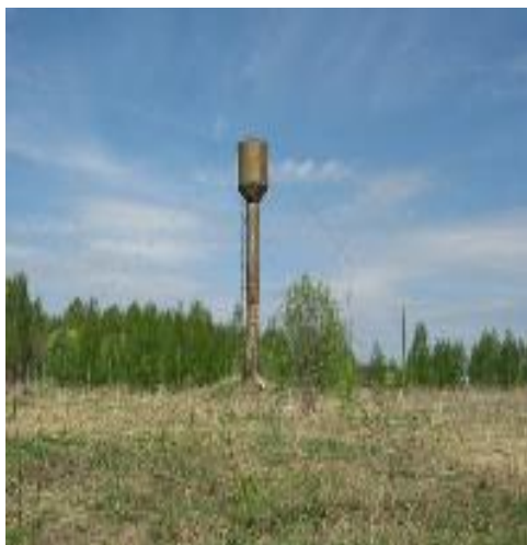
Павильон скважины, внутреннее расположение, водонапорная башня д. Незнано
