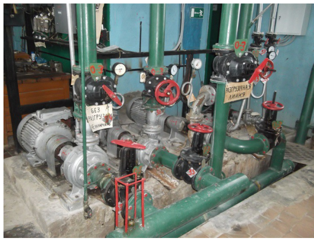
Фото 1.2.4 – котельная д. Лаврово, сетевые насосы
