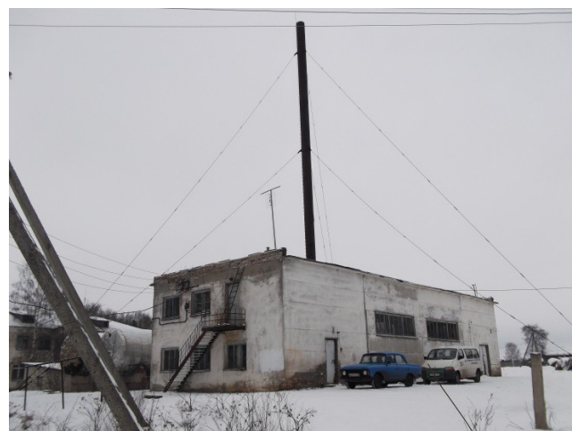
Фото 1.2.10 – котельная с. Григорцево, общий вид
