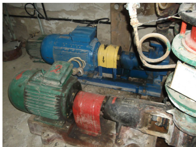
Фото 1.2.4 – котельная д. Лаврово, сетевые насосы
