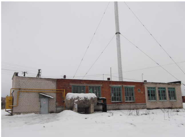
Фото 1.2.1 – котельная д. Лаврово, общий вид
